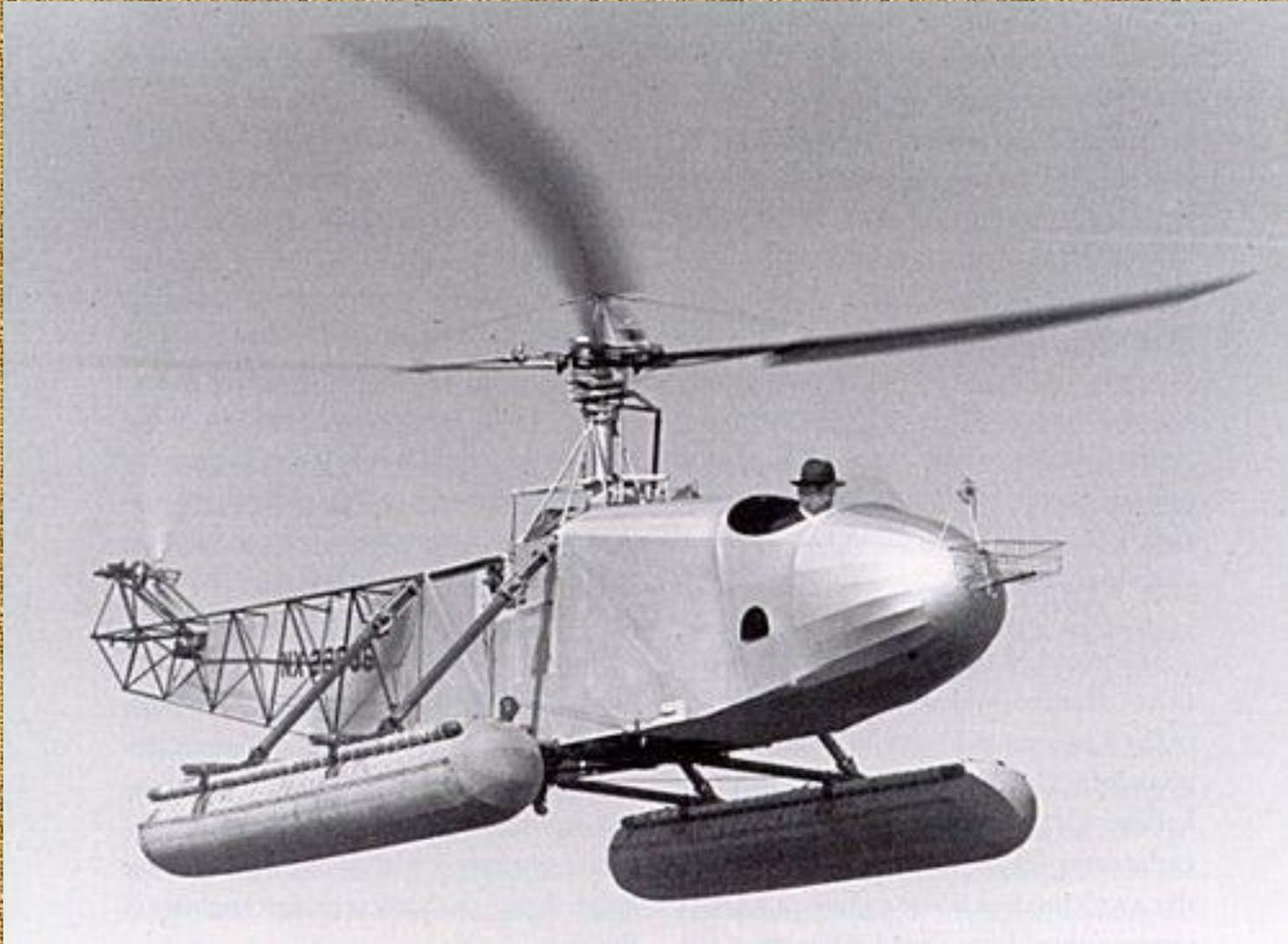
**En tournant, le rotor principal assure la portance et la traction de l'appareil.**
